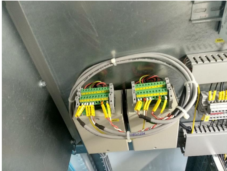
Слика 4.6: Уграђени мерни претварачи MPI и MPU
