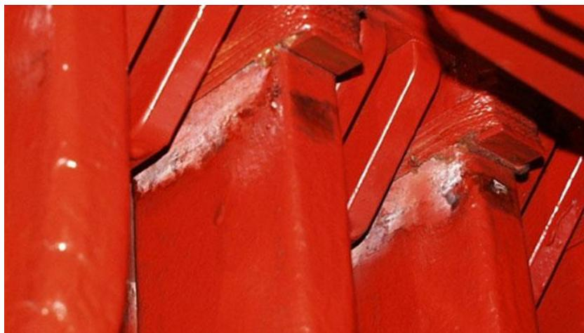
Slika 2.4 - Oštećena kanura usled mehaničkih oscilacija
